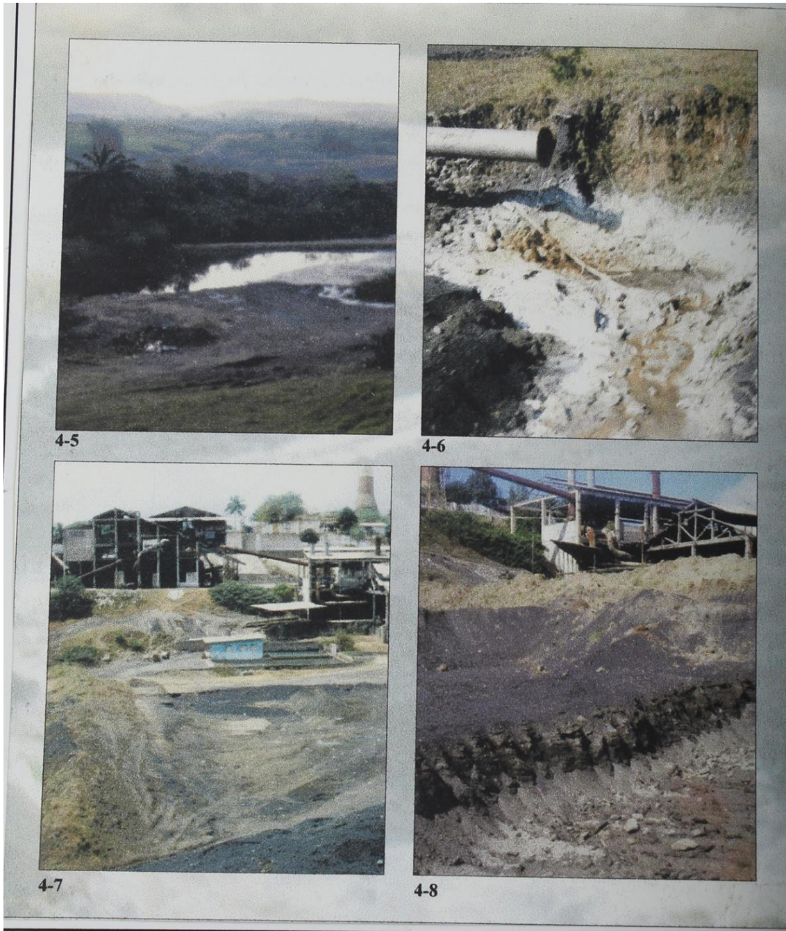
Fotos 4-5 a 4-8. As barragens de rejeito construídas pela Industria de Guardanapos Boca Loka apresentam diversas irregularidades (Fotos 4-5 e 4-7), entre elas a utilização da escória como material de base (Fotos 4-6 e 4-8).
