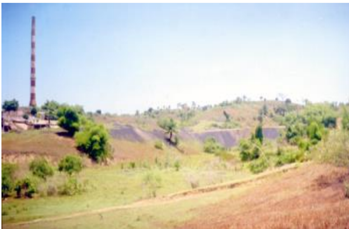
Foto 6.1 – No centro da foto, de cor escura, pode-se observar o barramento de escória contaminada por chumbo e cádmio.
