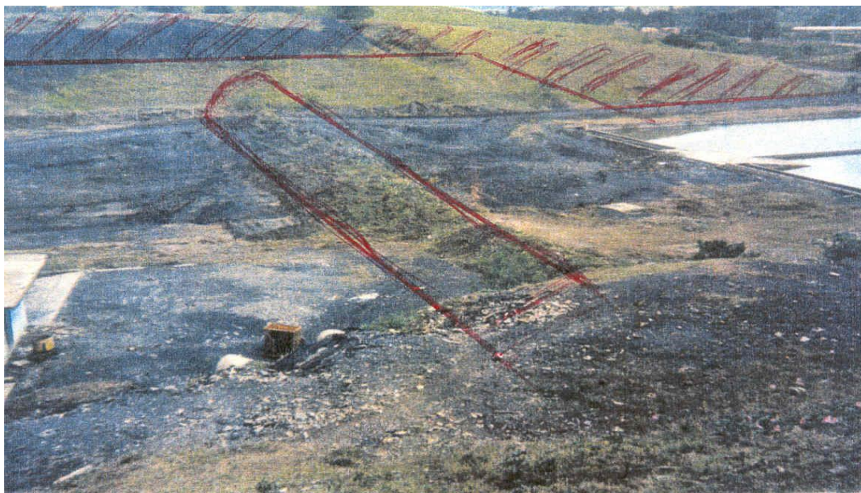
Foto 6.3 – Indicação do rebaixamento do morro e construção do dique.
