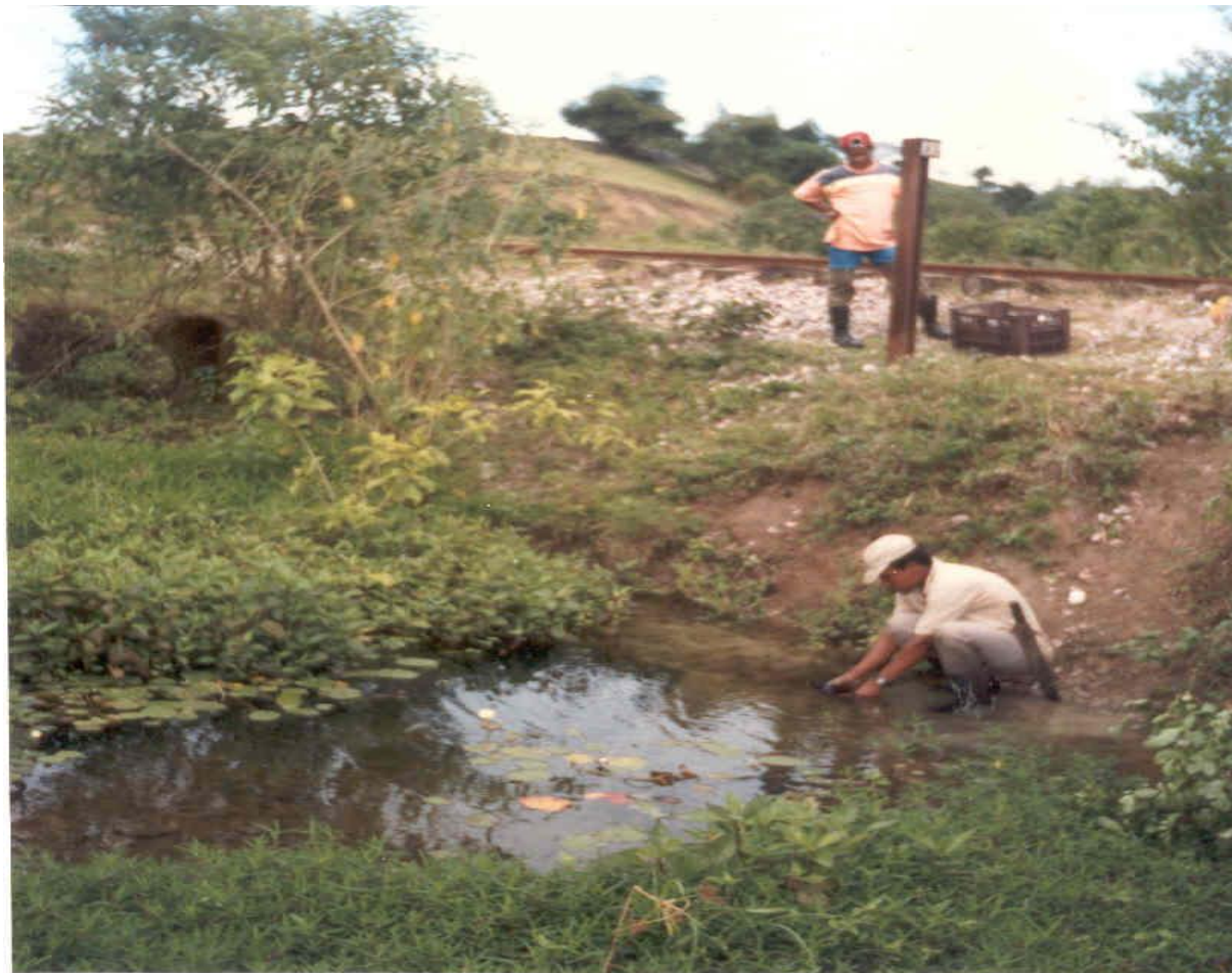
Foto 8.4 - Surgência das águas provenientes da tubulação (noroeste da foto) que passa abaixo da ferrovia e são oriundas da pluviosidade e águas acumuladas a montante do barramento da escória.
