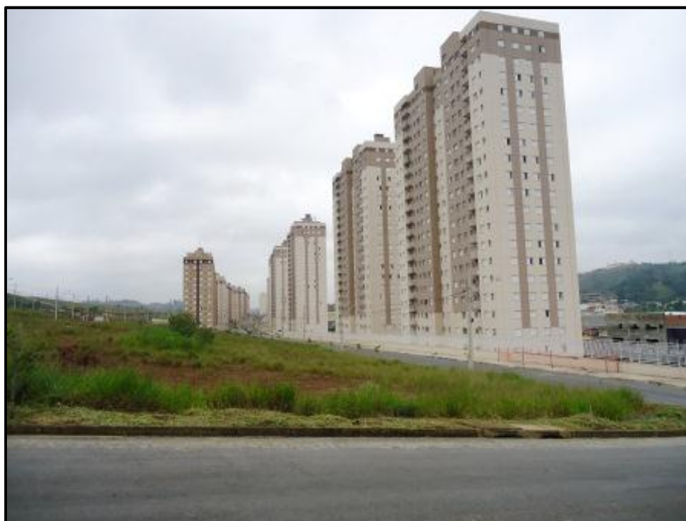
Fig 13 - Grande empreendimento imobiliário que teve uma segunda fase avançando sobre a faixa do vale aí presente, coincidente com o alinhamento cárstico Polvilho - Natura, apresentado grande concentração de vazios na interface solo/rocha, o que veio a demandar extensivo tratamento geotécnico por injeções de calda de cimento e adoção de estacas hélice contínuas como sistema de fundação. Foto ARSantos.
