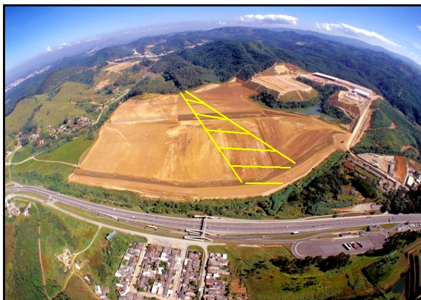
Fig 14 - Empreendimento imobiliário em que a prospecção geológica detectou faixa de concentração de vazios cársticos (linhas amarelas), coincidente com o alinhamento cárstico Lavrinhas. Foto ARSantos
