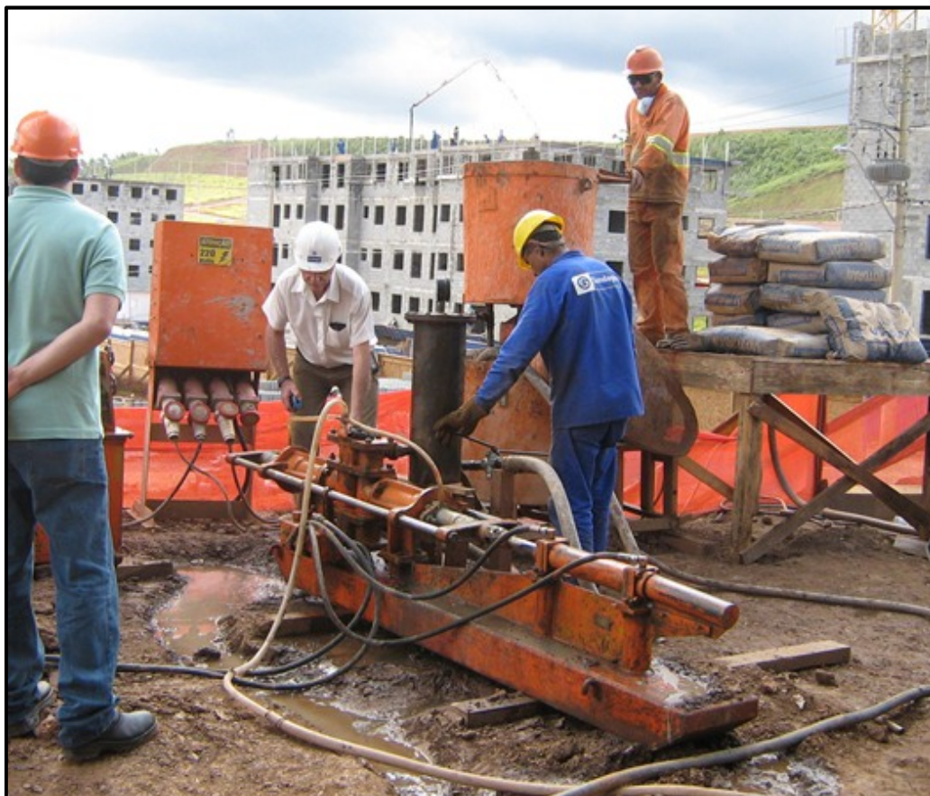
Fig 19 - Bomba pneumática utilizada para a injeção de calda de cimento com misturador acoplado. Foto ARSantos.
