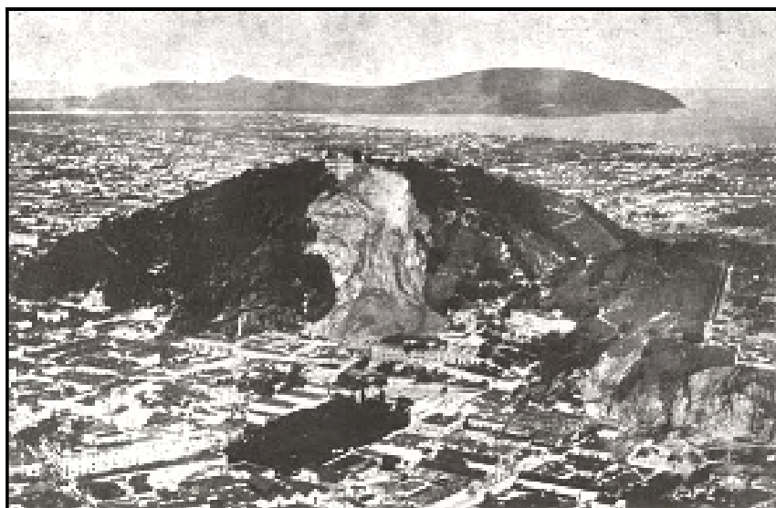
Foto panorâmica do extenso escorregamento rotacional profundo ocorrido no Mont Serrat em 1928 atingindo a parte anterior da Santa Casa de Santos e provocando a morte de cerca de 200 pessoas. Em 1956 um novo escorregamento no local causou graves danos patrimoniais e humanos. Escorregamentos desse tipo, rotacionais profundos, não ocorrem naturalmente na Serra do Mar. São sempre, de alguma forma, induzidos pela atividade humana. (Foto Arquivo Revista Solos e Rochas)
