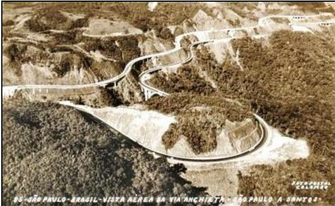
Foto da Via Anchieta no início da década de 60 mostrando o conceito básico do projeto, qual seja, uma estrada encaixada em cortes na encosta. Notar o alto nível de interferência com cortes, desmatamentos e lançamentos de material escavado nas encostas. (Foto Acervo Maria Cecília França Monteiro da Silva)
