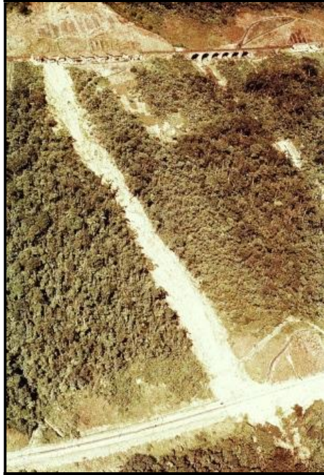
Deslizamento, provavelmente associado ao lançamento de material escavado encosta abaixo na época de abertura da ferrovia, faz ligação direta entre a Funicular (superior) e a Cremalheira (abaixo). Anos 80. (Foto Arquivo IPT)
