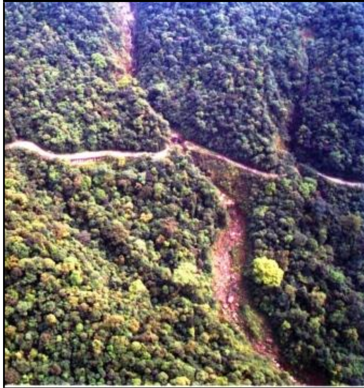
Corrida de detritos em drenagem que corta o Caminho do Mar. Essa corrida tem sido recorrente, a da foto é de março de 2022. Em março de 2023 houve nova reativação.
