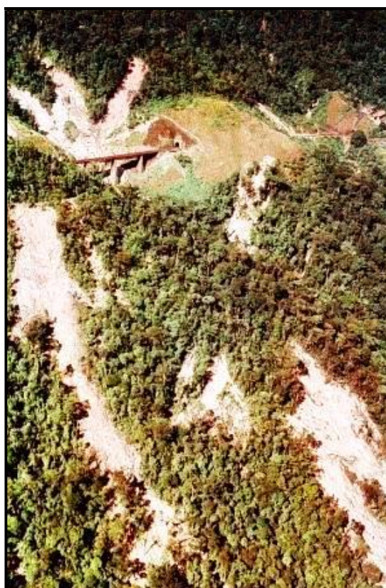
Série de deslizamentos que colocaram em risco a operação do sistema cremalheira. Anos 80. (Foto Arquivo IPT)
