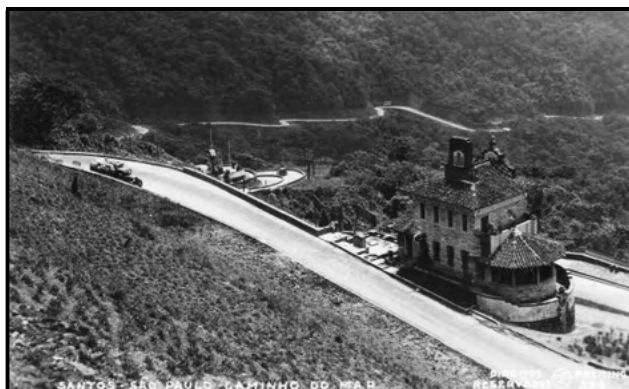
Foto do final dos anos 30, mostrando o Caminho do Mar já todo pavimentado em concreto. Em primeiro plano, o Rancho da Maioridade. Notar o conceito tecnológico de estrada encaixada na encosta. (Foto Acervo Maria Cecília França Monteiro da Silva)
