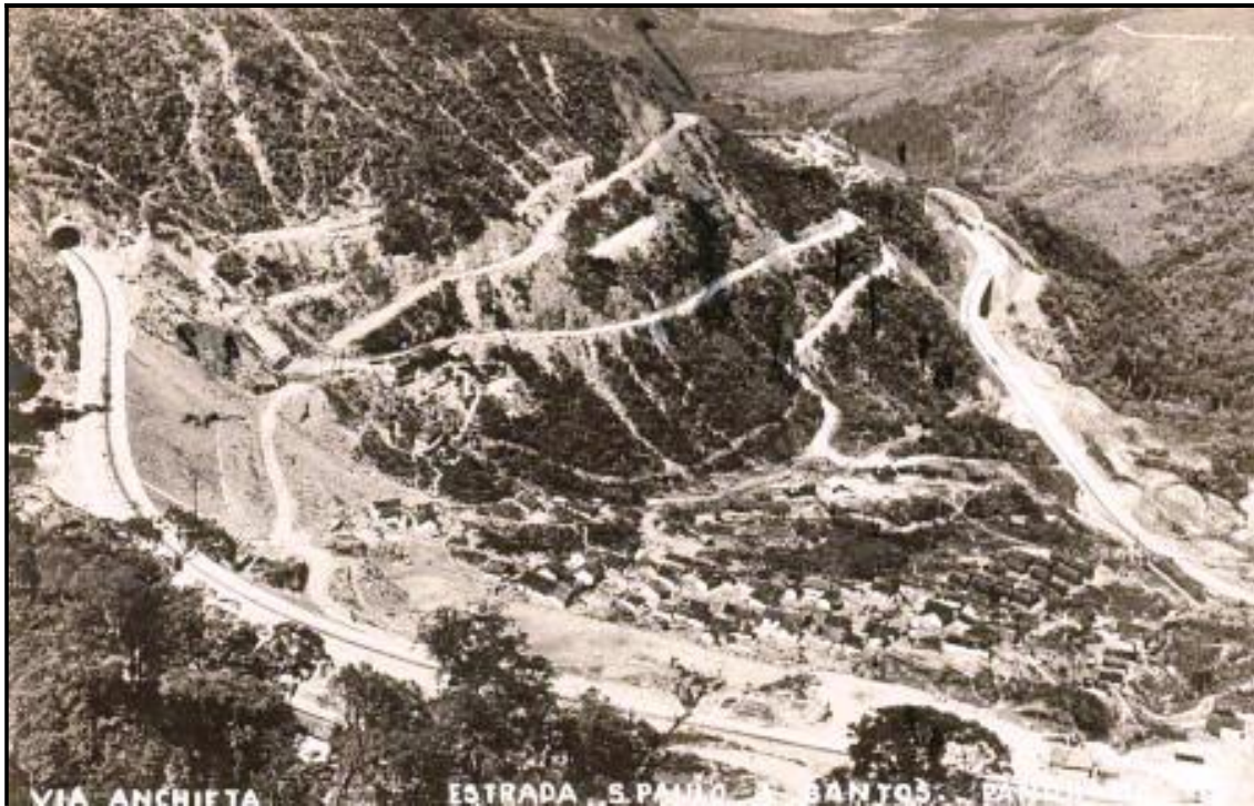
Via Anchieta poucos anos após a inauguração da primeira pista. Notar o alto grau de intervenção nas encostas pelo desmatamento, estradas de serviços e obras da própria estrada. (Foto Acervo João Emílio Gerodetti)
