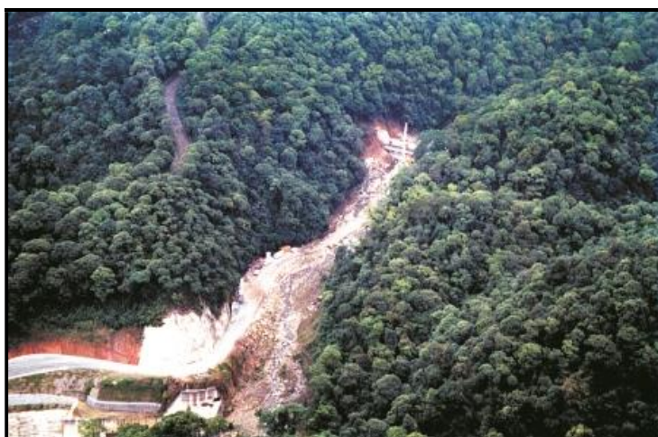
Foto mostrando deslizamento que levou à interrupção do tráfego normal pela estrada por vários anos. Notar a forma compacta com que as copas das árvores da Mata Atlântica se apresentam. (Foto Dersa)
