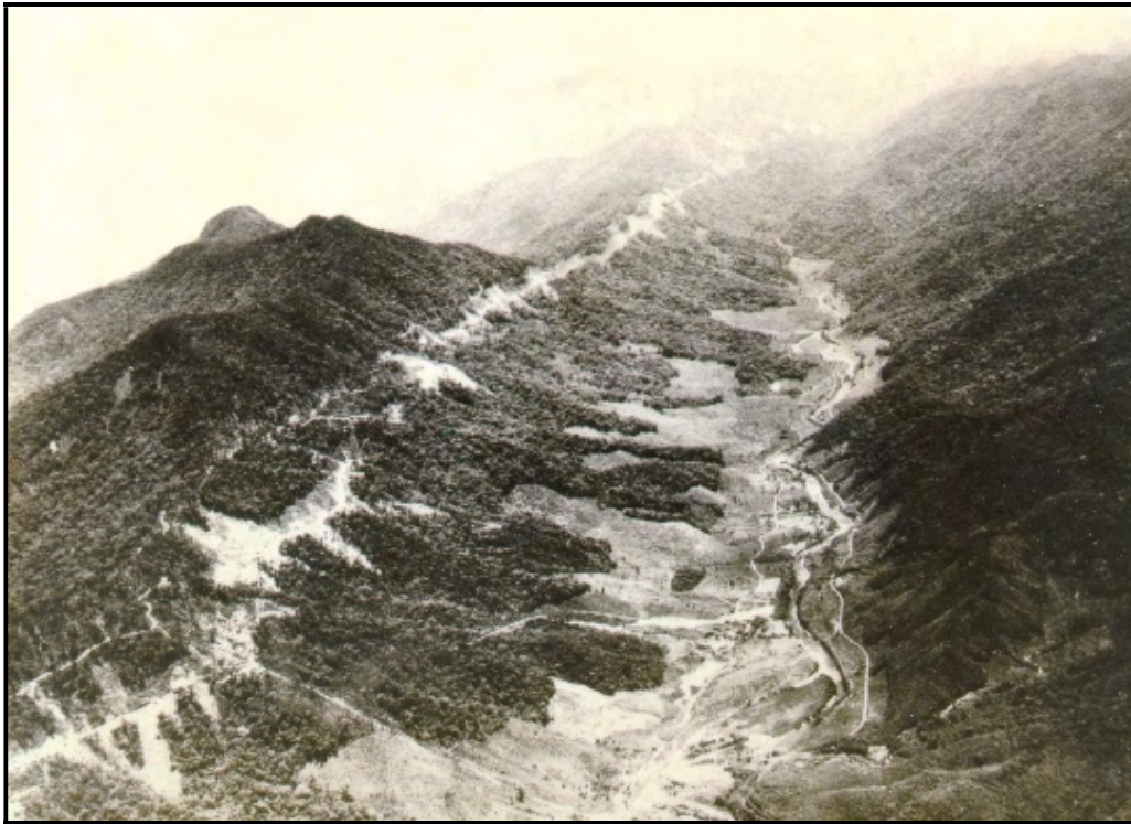
Foto de 1928 mostrando os trabalhos de construção da E. F. Sorocabana (E. F. Mairinque–Santos, na ocasião) na vertente direita do Vale do Rio Cubatão. Notar o hábito de lançar o material escavado imediatamente encosta abaixo. As extensas áreas desmatadas junto ao rio seriam mais tarde ocupadas por eucaliptais aproveitados como matéria-prima e fonte de energia por indústrias santistas. (Foto FPHESP – Arquivo IPT)
