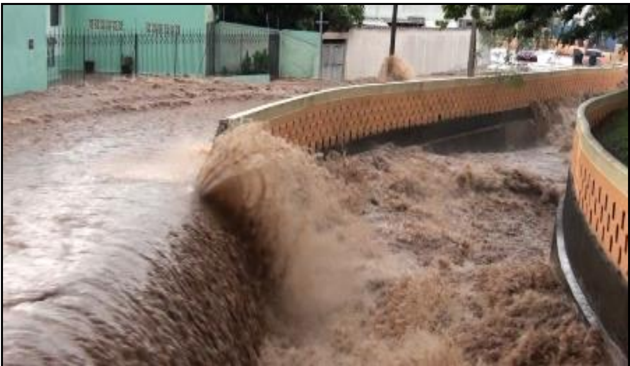
A cidade lançando suas águas pluviais em grande volume e pequeno espaço de tempo sobre seu sistema de drenagem, que nessas condições é totalmente incapaz de lhes dar a devida vazão
