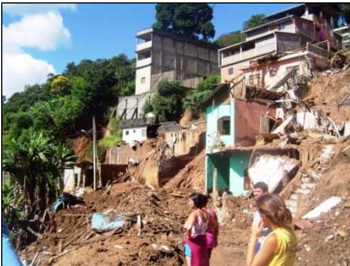
Sistemática ocupação de terrenos declivosos nas zonas de expansão urbana: uma sucessão de erros gerando áreas de risco mesmo em regiões que não demonstram alta suscetibilidade natural a deslizamentos. Acima, RMSP, abaixo, Nova Friburgo – RJ.
