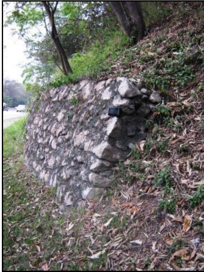
Pequeno muro de arrimo de pedras rejuntadas com argamassa.
