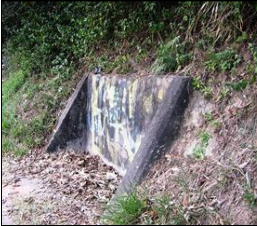
Pequeno muro de arrimo com parede sustentada por dois gigantes simples.
