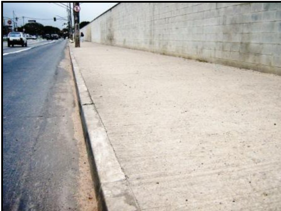
A atual incongruência impermeabilizante pró enchentes. Foto ARSantos.
