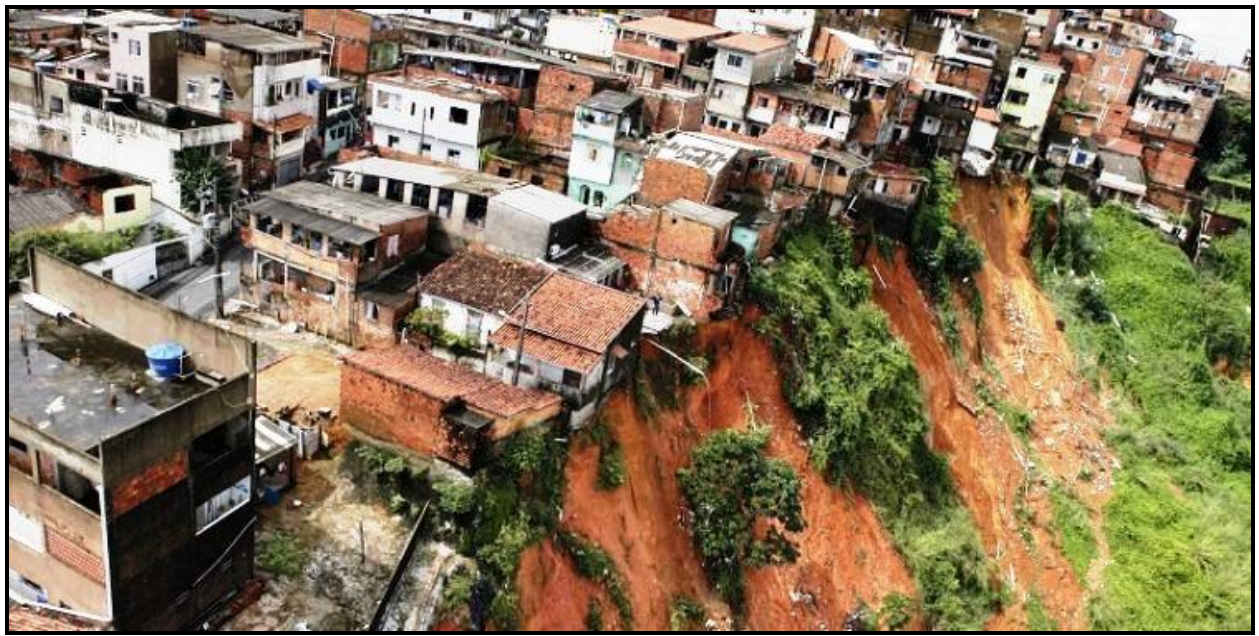
Áreas de risco assentadas em crista de encosta.
