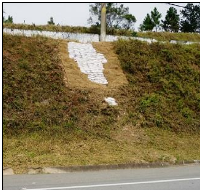
Obturação de erosão com sacos de solo-cimento
