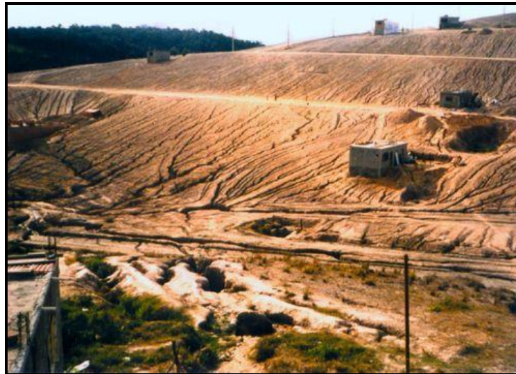
Loteamento irregular sem nenhuma infraestrutura instalada sendo destruído pela erosão. Foto IPT
