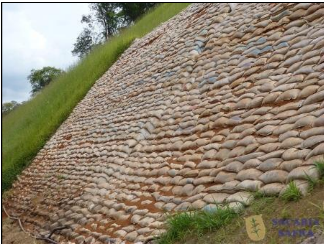
Proteção de talude com sacos de solo-cimento.
