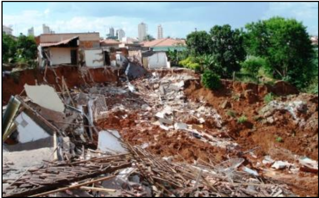
Um outro tipo de área de risco a deslizamentos: parte de bairro erroneamente assentado sobre antiga cabeceira de bossoroca aterrada. Com a reativação do processo erosivo houve uma corrida de lama implicando da destruição de mais de dez casas. Monte Alto SP. Foto IPT.
