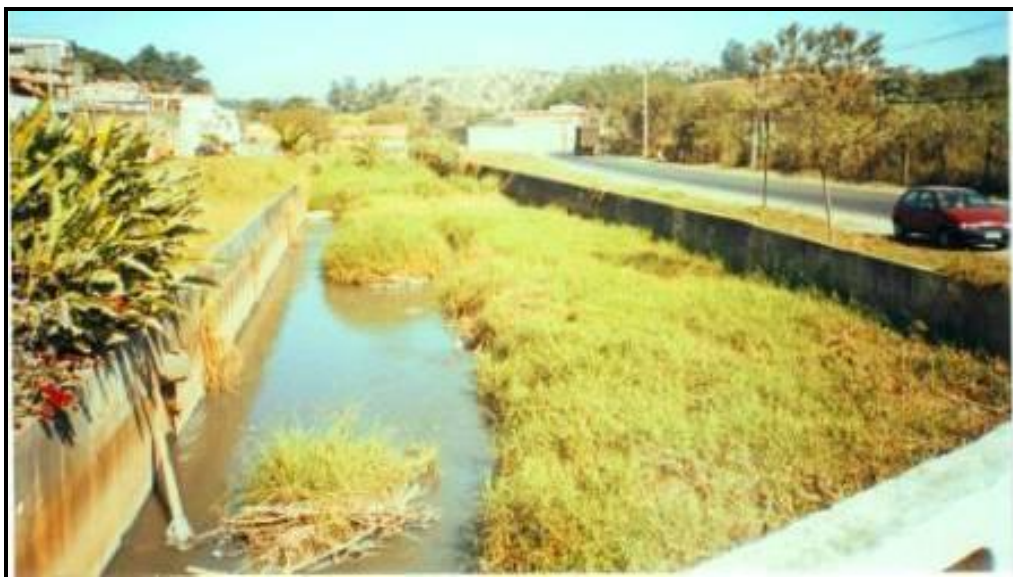
Incrível grau de assoreamento em um dos principais afluentes do Tietê. Redução de cerca de 80% da capacidade de vazão. Foto ARSantos.
