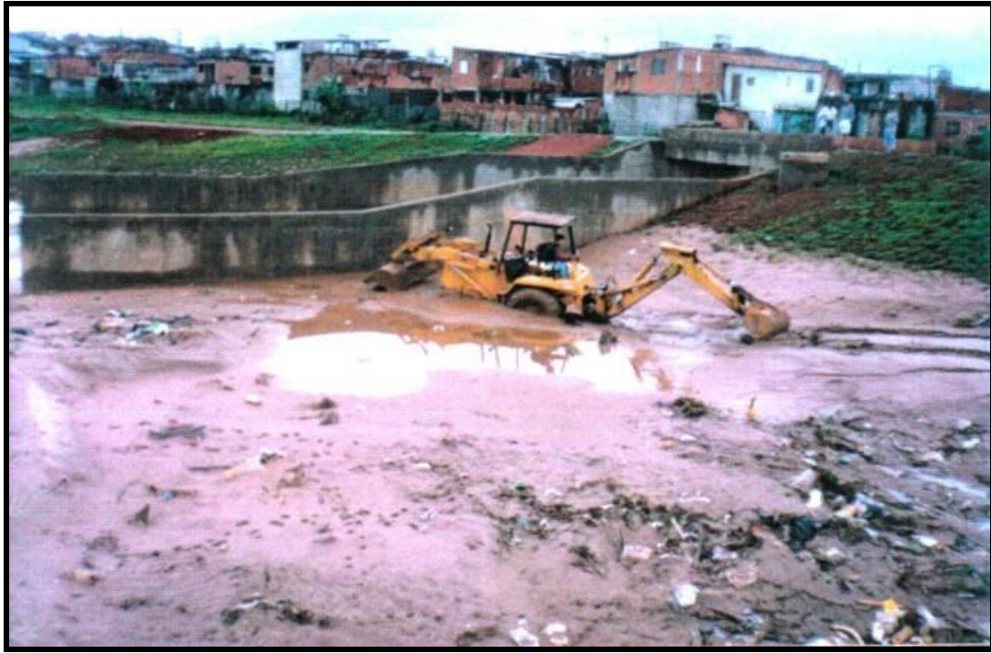
Assoreamento de piscinões. Foto ARSantos.
