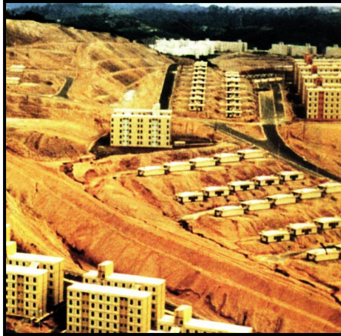
Conjunto Habitacional na RMSP totalmente degradado pela erosão. Foto IPT.
