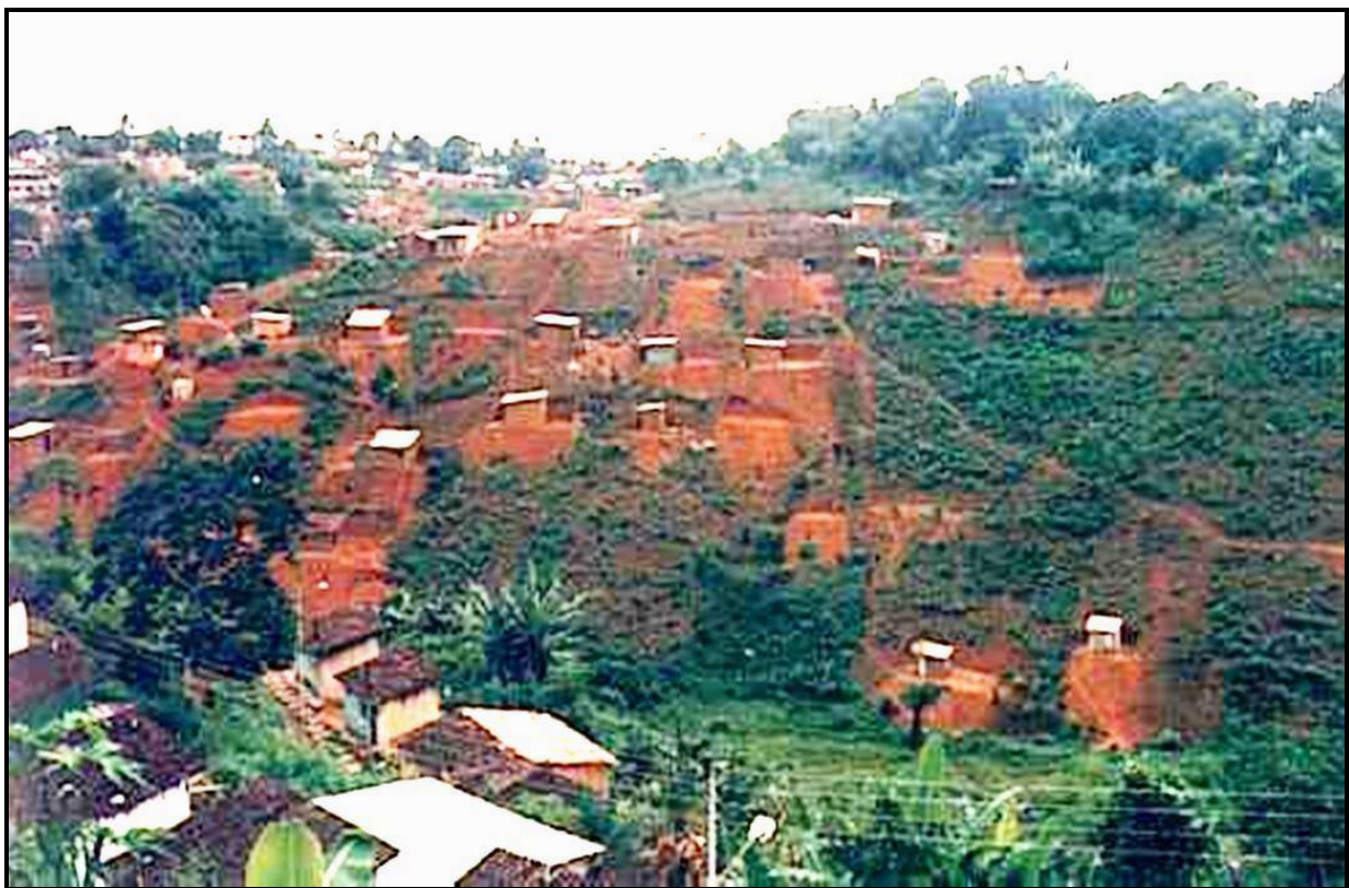
A trágica cultura técnica de cortar a encosta para a produção de platô a ser ocupado pela edificação. Desestabilizações sucessivas. Salvador – BA
