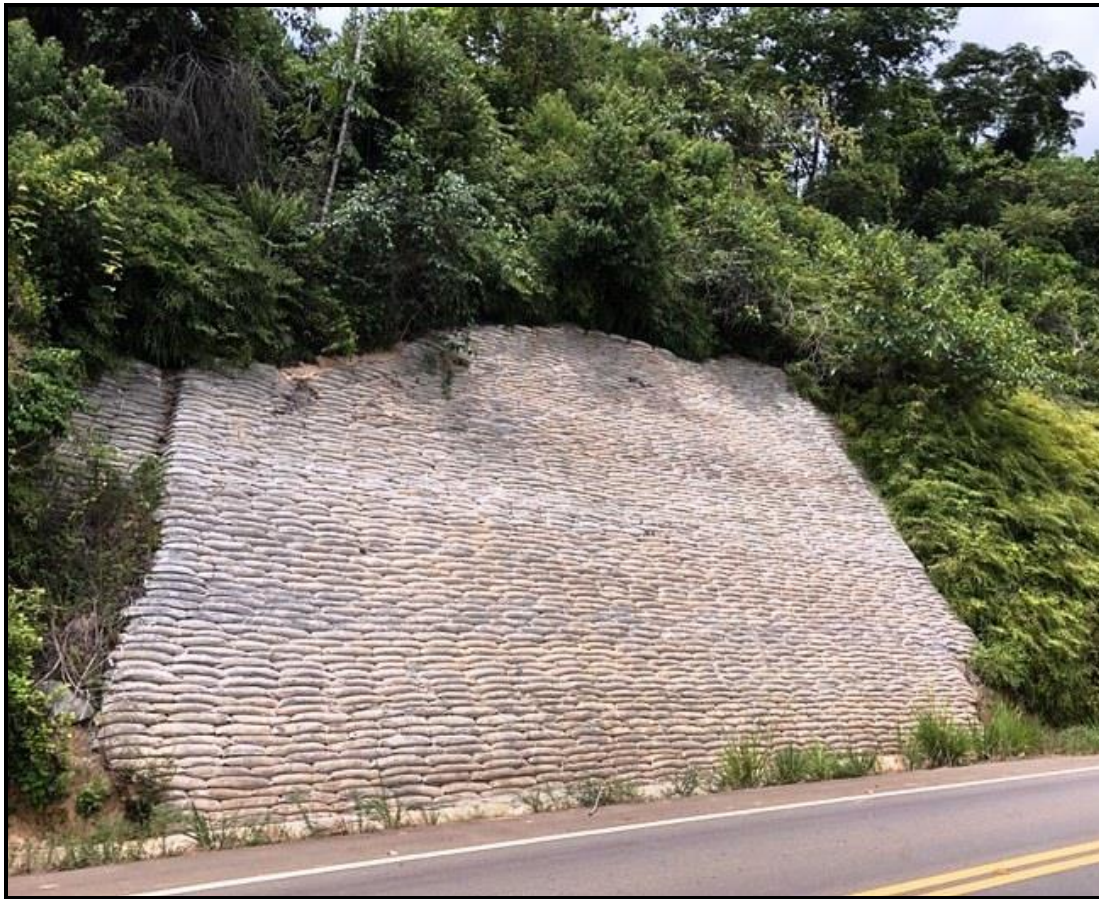
Exemplo de estabilização de talude com o uso de sacos de solo-cimento (rip-rap)
