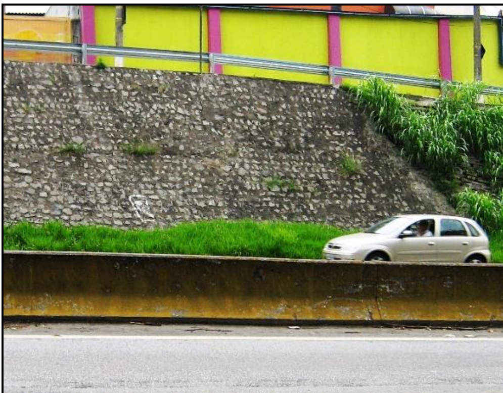
Exemplos de aplicação de Pano de Pedra na proteção de taludes viários
