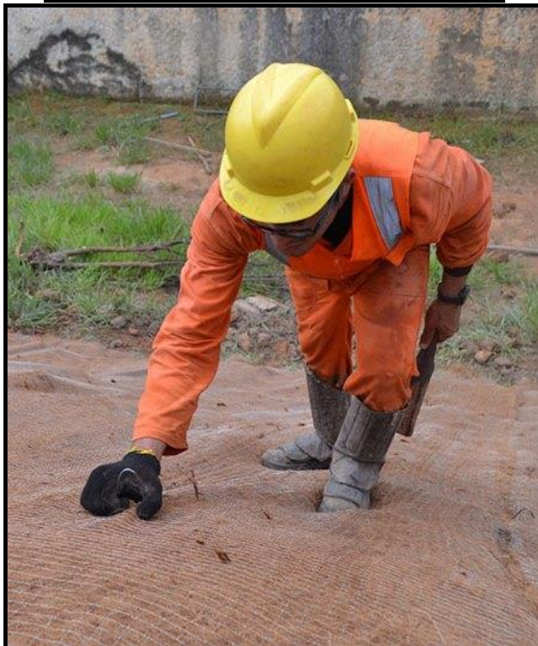
Colocação dos grampos
