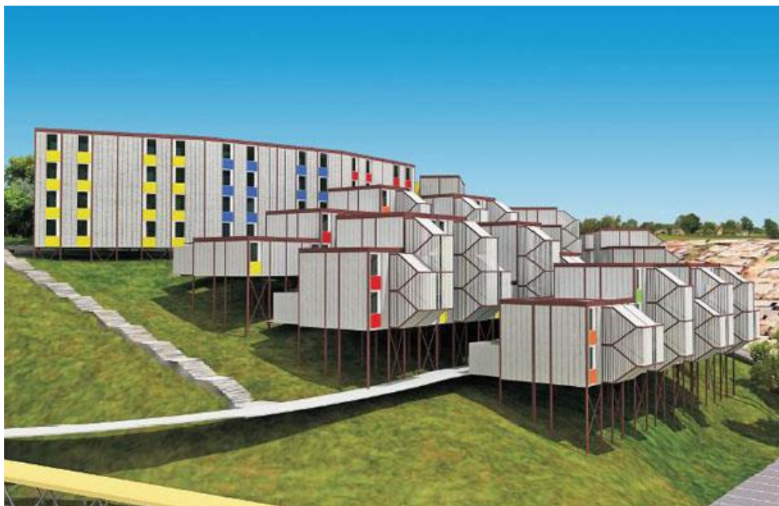
Concepções construtivas para terrenos de alta declividade. Proposta do arquiteto João Filgueiras Lima (Lelé) para o programa Minha Casa Minha Vida.
