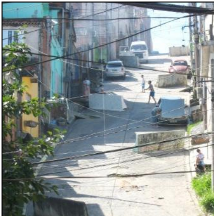
Rua em ladeira a 30% de declividade corretamente ocupada por casas justapostas sem cortes no terreno. Bairro do Tucuruvi, São Paulo. Foto ARSantos
