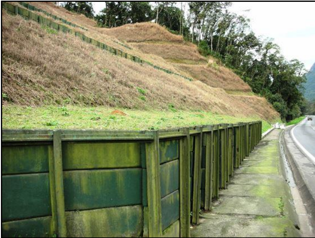
Contenção com utilização de pranchões e sobras de trilhos ferroviários.
