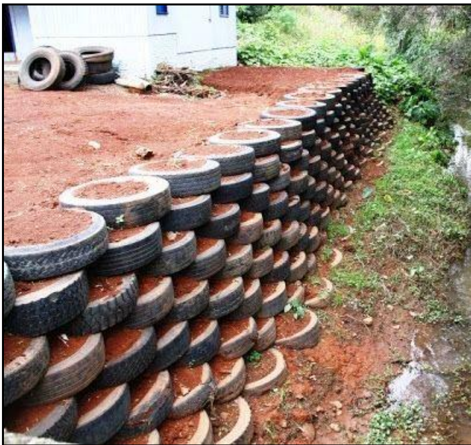
Contenção com a utilização de pneus usados
