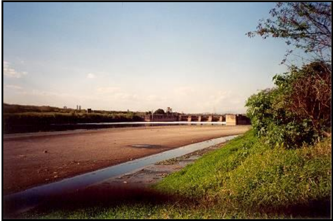
Assoreamento extenso no próprio rio Tietê. Foto ARSantos
