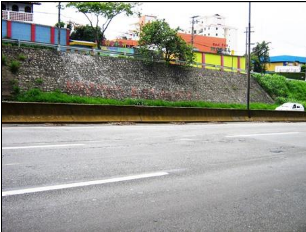
Pano de pedra (pedras rejuntadas com argamassa) protegendo talude de erosão e desagregação.
