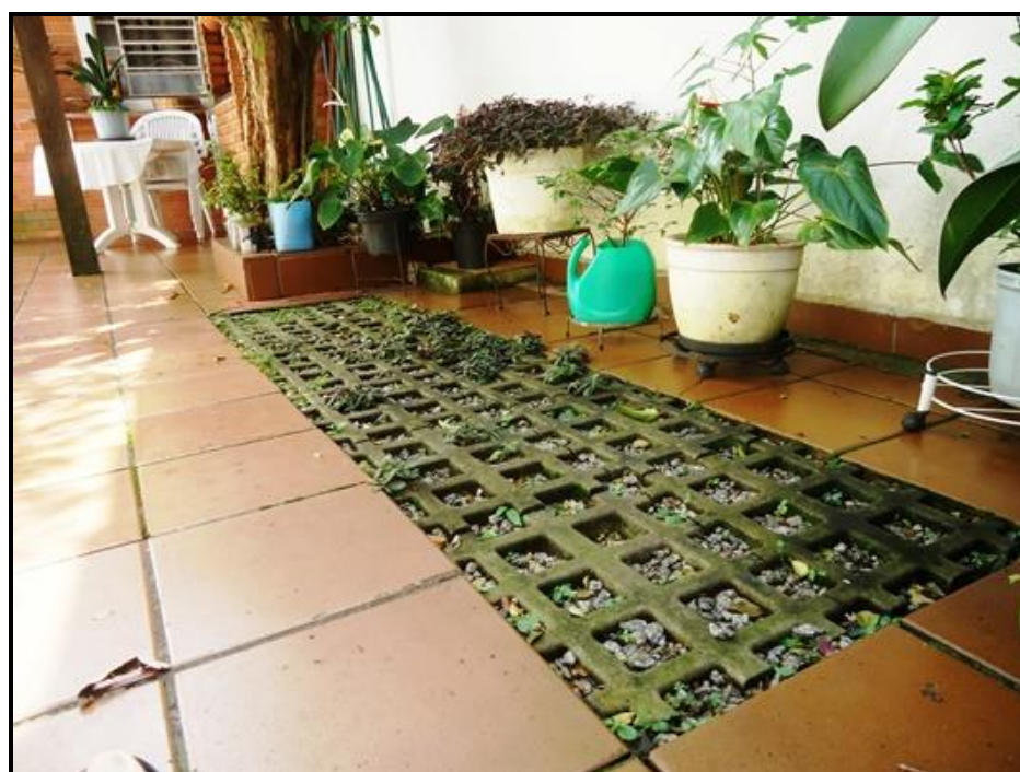
Trincheira drenante implantada.
