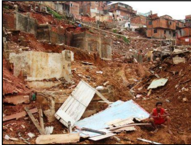
Auto construção sem qualquer assistência técnica criando áreas de risco. Fotos ARSantos
