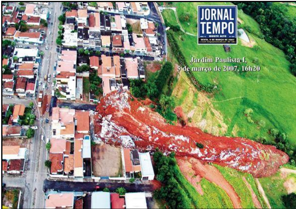
Bossoroca, que teve sua “cabeça” aterrada para receber ocupação urbana, reativada pela concentração de fluxos de água profundos e superficiais. Monte Alto SP. Foto Jornal Tempo.
